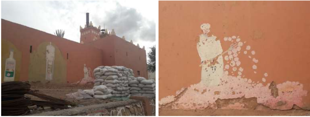
Fig. 3 : Photos de la façade de l'usine Les arômes du Maroc (Clichés : Master EDEV, février 2017)
